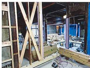
写真は現在工事中の耐震工事の現場。床下に土間コンを打ち、新しく土台を入れ要所に筋交いを入れています。
