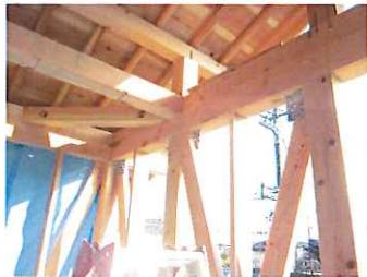
⑱梁、桁、柱などに金物を取り付けていきます。
