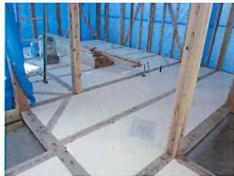
⑲1階床の断熱工事。次世代省エネルギー基準にて施工。
