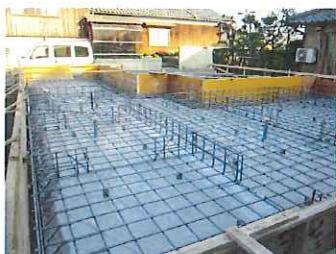
⑨鉄筋工事完了。20cm四方で整然と組まれた鉄筋。
