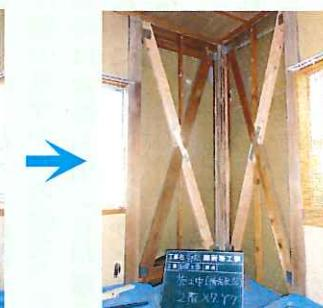
着工前は片筋交だった壁。筋交を足して両筋交に。補強金物でしっかりと固定し構造用合板を張りました。
