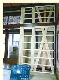
←2階の壁。既存の壁をめくり、間柱と間柱の間に筋交いを入れ、金物でしっかりと固定。さらに構造用合板を張り強度を高めました。
