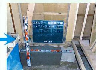
着工前、土台の下に基礎がない状態。型枠をして鉄筋をいれ、コンクリートを流し込み基礎が完成。土台と基礎を固定します。
