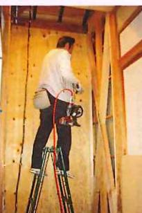
↑上3枚の写真、押入れだった場所を解体し、両筋交を入れ補強金物でしっかりと固定し、更に構造用合板を張ります。
