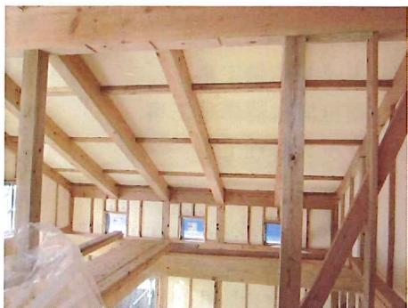
屋根と壁の断熱材を入れた様子。
