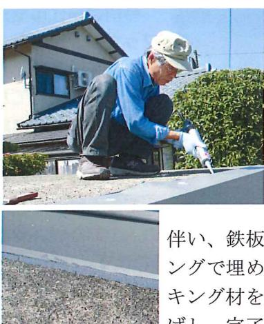
伴い、鐵板と屋根との隙間をコーキングで埋める作業をしました。コーキング材を打ち、へらできれいに伸ばし、完了。忙しいこの時期、近藤さんの「作業スキル」はムラケンにとってかなりの戦力になっています。
