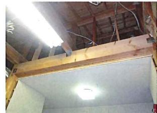
↑解体状況。入口を引き戸にするために不要な柱は撤去しましたが、構造上はきちんと補強します。
