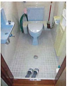
→便器の右に見えるアームレスト手摺りは、上げ下げ式なので邪魔にななりません。窓枠は交換しましたが、窓自体は既存のまま。その窓を残したまま、鏡や手洗器がうまく納まるよう、カウンターブランを設計。ほぼ全てのセンサー機能を備えたので、ウォッシュレット機能を使わない時の動作としては紙巻を取って拭くくらい。便座蓋も洗浄ボタンも触る必要がありませんよ。
