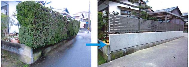
【当社施工事例】垣根を撤去後、既存の擁壁の上にコンクリートを打ち増しし、アルミのフェンスを取り付けました。フェンスは三協立山アルミさんの製品です。
