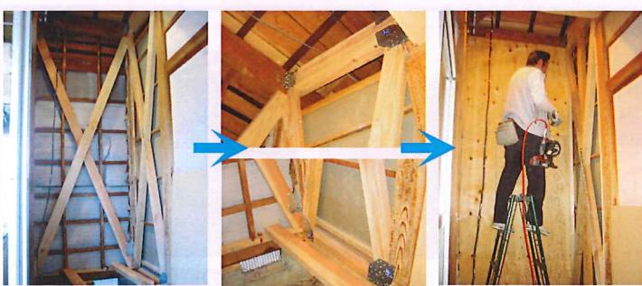
↑上3枚の写真、押入れだった場所を解体し、両筋交を入れ補強金物でしっかりと固定し、更に構造用合板を張ります。
