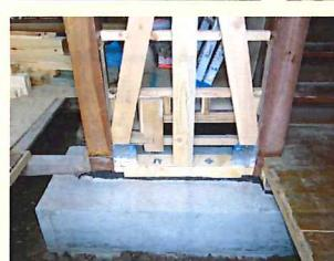
↑和室の4枚引き戸の一部を耐震壁に。新しい壁の部分に筋交いを入れます。和室の真壁なので、施工も少し複雑です。
