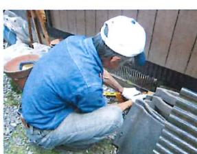
←床下の換気口から小動物が入るとの理由で、換気口を長年塞いだのも、床下が湿気の要因。この場合は大きめの換気皿を基礎にビス止めします。これで小動物の侵入も、床下の換気の流れも解消しますよ。近藤さんが取付けている様子です。
