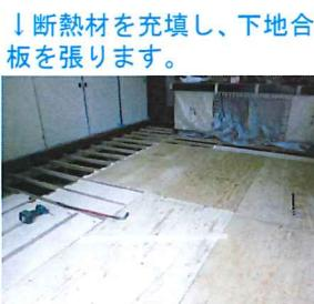
↓断熱材を充填し、下地合板を張ります。
