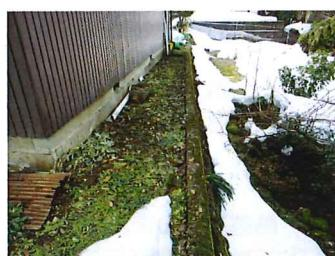
⑯雨排水が直接土の部分に流れています。長年の雨排水により土が削り取られていたのが、基礎の亀裂の原因だと考えられます。
