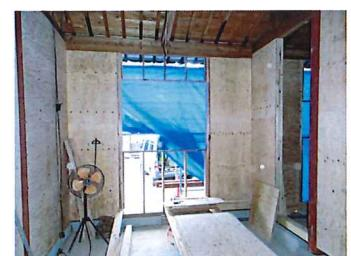
⑮さらに構造用合板を取り付け、耐震性を上げます。
