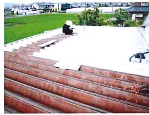
・大規模な2階の改装工事をさせて頂いています。この丸太組み凄いですよね。大工さんは耐震補強中。外部にこのような大きな作業デッキを組んで資材の搬入や作業員の出入りをしています。10月末頃の完成です。お楽しみに。
