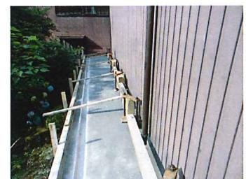
⑲雨排水用の側溝を設け、擁壁までコンクリートを打ちました。
