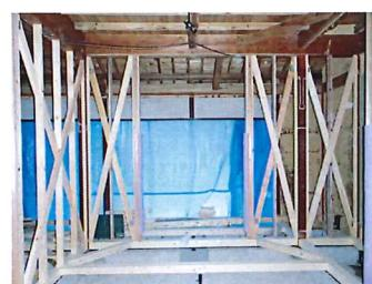
⑭筋交いは金物でしっかりととめていきます。また柱と梁、柱と土台も金物でとめていきます。
