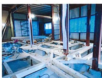
⑫床組み：水平面の強度を出すための下地を行っていきます。
