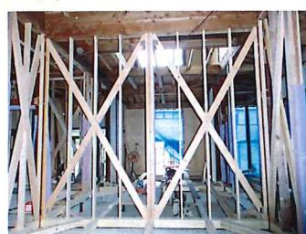
⑬耐震工事：耐震設計した部分に筋交いを入れていきます。
