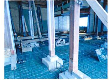
⑦鉄筋工事：基礎と立ち上がり部分の鉄筋を組んでいきます。
