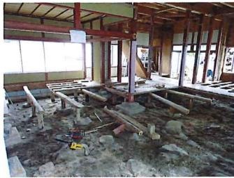
④床・壁・天井を解体していきます。床組みも壊していきます。床下の土が見えてきました。
