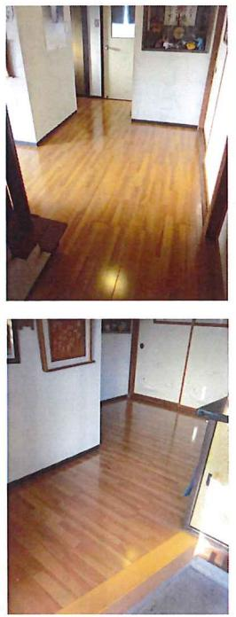
→既存床に上張りした現場。既存床をビスで頑丈に床垂木に締め直して、上張りします。壁をさわらないで上張りするこの技術はめすごく難しいので、実は大工さんは大変です。特に廊下など狭い凹凸が多いと難しいのですが、仕上りは大した出来きでした。玄関もリフォーム框を取付けて施工しています。
