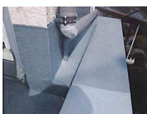
さがより大切で、仕様通りの塗膜厚がないと意味がありません。塗膜防水は液状の為、継ぎ目なく施工できるので形状が複雑な場合に適しています。あとメンテナンス性に優れており、定期的に行うと防水性能を延ばし、長い目で見てもなります。改修タン素材を使うことで、長い目で見て、屋上の防水つるるので、室内側にい限り後回しに年以上前にした陸査させて下さいね。お気軽に電話下さい。
