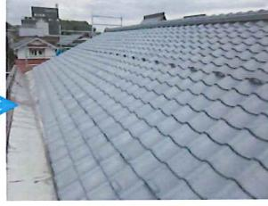
■鉄骨倉庫の屋根と外壁修繕工事をさせて頂きました。屋根の瓦棒葺きはカバールーフにて施工。手動シャッターも入替え、あとは外壁をニュー角張りにて完成です。
