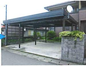
■鉄骨車庫の修繕工事をさせて頂きました。鏽を落とし、下塗り1回、上塗り2回。折板屋根は張替え、幕板と雨樋も取替えました。北面に一部、吹雪き込み対策用にポリカ囲いを。照明もスイッチからセンサーに取替えたことで夜間とても使いやすくなりました。母屋との色合いが合った車庫に生まれ変わりました。
