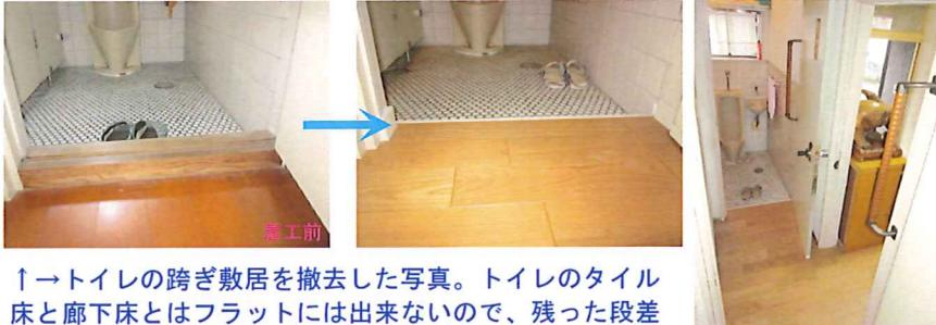
↑→トイレの跨ぎ敷居を撤去した写真。トイレのタイル床と廊下床とはフラットには出来ないので、残った段差は縦の手摺りを取り付けてサポートします。
