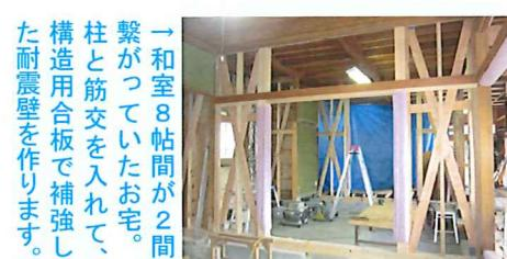
→和室8帖間が2間繋がっていたお宅。柱と筋交を入れて、構造用合板で補強した耐震壁を作ります。
