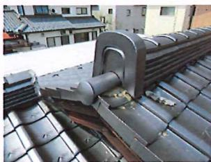
屋根塗喰が剥がれずれ落ちています。このままにしておくと、棟瓦の下の屋根土が雨の影響で流れていきますし、雨も浸透しやすくなります。
