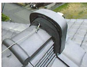
瓦部分は大丈夫でも、塗喰モルタル部分は痛みが早いです。早めのメンテナンスをする事により、長持ちした瓦葺き屋根を保てます。
