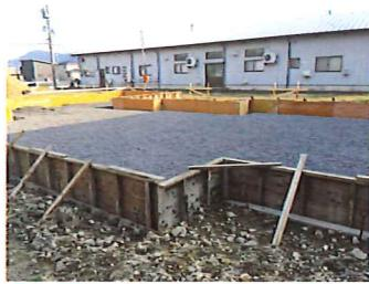
④碎石を敷き転圧をした後、型枠を組みます。
