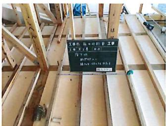
⑰床下地。大引きと大引きの間に断熱材が入っています。
