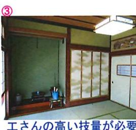
一仏間部屋を母寝室としたので、仏間を隣の床の間へ移動しました。床脇部分だけを壊し、既存の床板・床框・落とし掛け・床天井は新仏間で包み込むように施工しました。大工さんの高い技量が必要とされる工事箇所でした。
