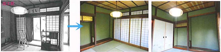
↑大工工事は天井板の張替えと畳下の縁板の張替え。内装工事としては襖戸の新設や、障子・畳の張替えをしました。コンセントやエアコンを室内に取付けると無機質な感じが出て、雰囲気が壊れるので、縁側回廊の一番奥にあった昔の雨戸の戸袋スペースを利用しました。部屋の内部からは直接見えないように工夫しました。
