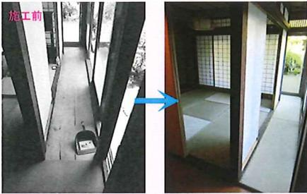
↑今はサッシが付いていますが、昔は外部縁側であったらう部分には隙間が多く、サッシ上部の鴨居の長押し部分を上から覗いてみると、やはり外と繋がってました…。これだと虫は自由に侵入できますね。外からは埋め木をし、中からは見えない部分でパテ埋めました。工事完了後は虫の侵入がなくなったそうです。
