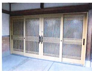
↓道路にすぐ面している玄関の位置を西面から東面に替え、ポーチを設けました。玄関の段差も解消して全体的に玄関先を緩やかにしました。二期工事で玄関ポーチの柱と外壁の間に面格子を取り付ける予定です。
