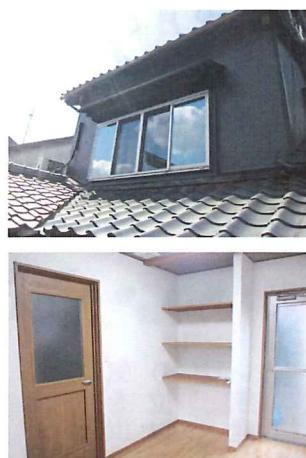
↑今回の工事で少し収納室を増築し、外壁材は金属サイディングで仕上げました。ちょうどエコポイント重なり、外装工事に伴う窓は全てアルミの断熱サッシに交換。下地の際には断熱効果をより高めるため、壁内に断熱材を充填しました。
