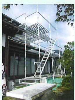
→ 2階の工事では作業員の昇降も兼ねたデッキを組みます。
