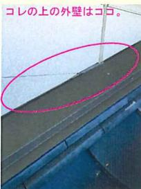
などを逃がすためにも隙間が設けられています。それらを塞いで密閉してしまう事は木造住宅の設計施工として認められていません。雨漏りしたが、今回ばかりは仕方ないという事例も多くありました。ムラケン南部の家も今回の台風で初めて雨漏りした箇所がありました。その部分の外壁側をみてみると、ちょうど下屋の屋根と外壁との取合い部分でした。今回はここから浸水したケースが他にも多くみられました…。
