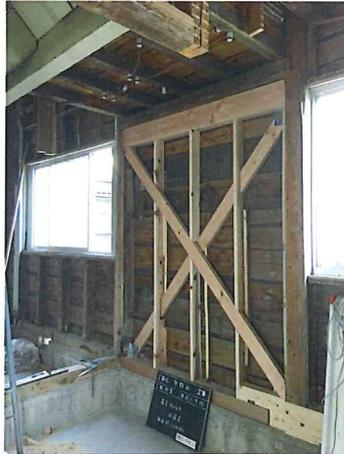
筋交、新設された梁によって補強される壁。
