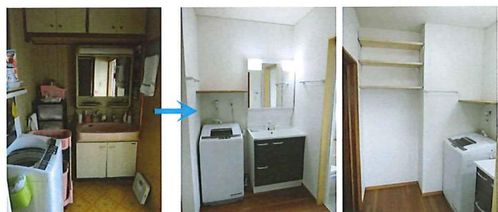
↑外開きだとトイレのドアとぶつかるので、内開きですがドアをつけるために洗濯機の配置を替えました。浴室-脱衣室間の間仕切り壁を10cm広げて、洗面台横にギリギリ洗濯機を配置できました。床も腐りかけカカフカで、ジメジメしていた脱衣場ですが明るく気持ちよくなりました。
