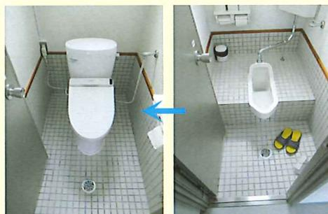
■工場の数あるトイレの中の1カ所を和式から洋式に交換しました。土間部分を一部解体してトイレ復旧していただきます。多くの社員が使うので節水効果は大きいですね。
