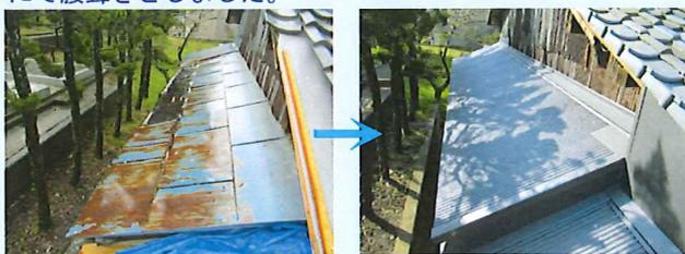
↑追加で頂いた東側の下屋はガルバ鋼板の波板葺きにしました。ホームセンターなどに置いてある波板とかは0.16mmでとても薄くすぐ曲がったり凹んだりするので、外壁や屋根材で使うのと同じ0.35mmのものを使用しました。
