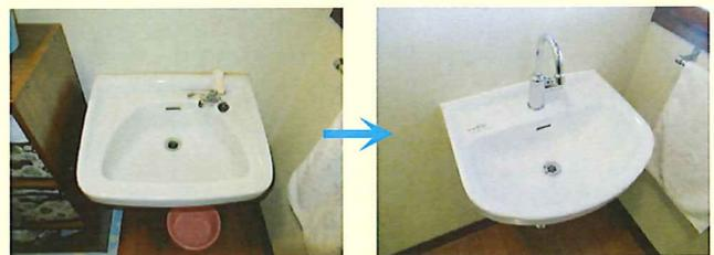
■排水管が経年劣化にてひび割れ水が漏れていました。クロスを張り替えなくてもいいようによく似た大きさの手洗器を探しました。水栓金具もバケツに水が汲めるように工夫しました。
