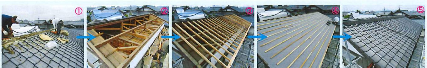
■福井豪雪の時に北側屋根の軒先が折れてしまった屋根の修繕をしました。まず、①屋根下地を直すために瓦屋さんにめくってもらいます。②折れた垂木と裏板ベニヤを解体して、③以前よりも厚い垂木を入れ替えます。④防水シートを張って、⑤瓦を復旧して完了。同時に傷んだ、軒天と雨樋も交換しました。5月は暑すぎず雨ふらず、ホント屋根メクリに最適な気候だと思います。
