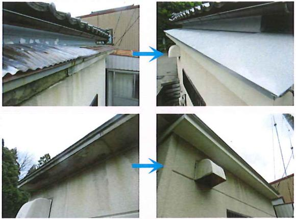
■長年の雨漏れにより傷んだ掛け屋根を修繕しました。壁との取合いの納まりを考慮し、端口は木材を晒さずG型鋼板巻きとしました。掛け屋根の修繕って、屋根の下になって狭かったり、既存の壁との取合いがあつたりして意外と難しいものなんですね。なるべくシンプルに且つ施工金額が高くなり過ぎない様にいつも心掛けます。
