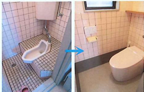
↑店舗のトイレ改裝をしました。奥行が1.2mほどしかなく、ここでタンク式の洋便器にすると狭くなるので、タンクレスにする事を勧めました。不要な土間部分だけ解体してモルタル土間下地をし、シート張りで仕上げます。欠損する壁タイル部分はモルタル下地して医療施設などで見られるガード巾木を張ります。これで壁を解体することなく、土間上りの和式便器から洋便器へ最小限に工事することが出来ますよ。
