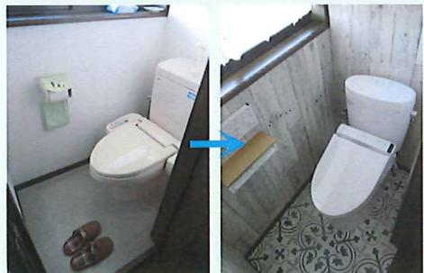
←↑2階のトイレの入替えをしました。ついでに壁天井クロスと床のクッションフロアの張替えもしました。内装材を変えたらガラリと雰囲気変わりましたね。同時に2階の洗面台の入替えと一緒にクロスの張替えもさせて頂きました。水廻りの設備が新しくなると、とても気持ちがいいですね。
