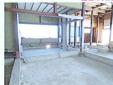
ベースの土間を打ち、立上りの基礎に土台をのせ、柱と柱間を連結します。
