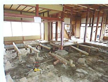
柱の下のみコンクリートを打たれた基礎の状況
