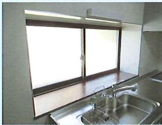
↑今期、私の最初のスタートはキッチンリフォーム。クリナップのシステムキッチンと食器収納棚をいれ、窓もペアガラスに入替えて断熱効果もアップ。流し前に出窓がある場合、棚板を新設して他三面はキッチンパネルを巻き込むように施工します。西北にあるキッチンですがとても明るくなりました。
