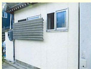
■木製の4本引き違いの玄関戸からアルミの玄関戸に入れ替えて頂きました。また浴室は新しいUBですが窓だけが古く、単板のため結露と寒さがひどいとのことで、UBと脱衣室の内装はそのままに、外部側から窓を入れ替えました。
