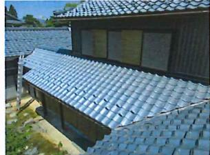
■豪雪や台風により傷んだ下屋の瓦を葺き替えさせて頂きました。一部雨漏りする部分は屋根下地から修繕しました。
