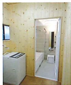
【温湿度対策】浴室への出入りで、湿気が洗面所に流れ込みます。浴室の換気扇だけでは排出しきれないでの、洗面所には必ず窓を設けましょう。おすすめは、室内に風をとり込みやすい縦すべり出し窓。また、湿気対策として内装材に無垢材の使用をお勧めします。木は湿気をすつたりはいたりするので、当社では無垢材にて施工する場合が多いですね。
