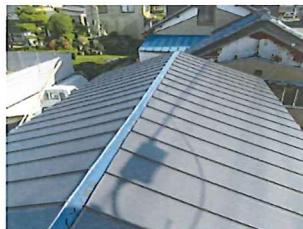
■小屋の屋根の葺き替え(施工中)。棟笠木をして完成。
