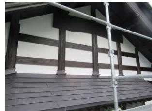
■外装工事をさせて頂いています。伝統的民家活用推進事業の補助金を利用しての工事です。木部を塗替え、傷んだ白壁は落として、モルタル下地後、漆喰白壁を塗り直します。2階外壁部分が仕上がり、次は下屋の瓦葺き替えになります。
