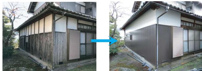
■板張りと塗り壁の外壁でしたが、経年劣化により傷んできたので修繕しました。鉄板で上張りしました。
