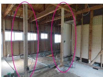
↑→間仕切られていた空間を解体しました。梁を補強することで、柱も撤去し大きな空間に。
