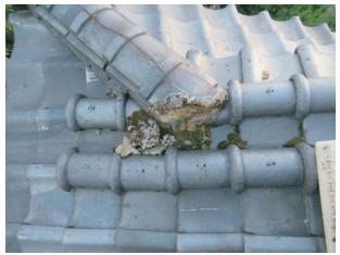
↑ 隅棟の漆喰モルタルが傷むと、中の瓦土がボロボロと流れ出でて雨漏りや崩れの原因になります。
