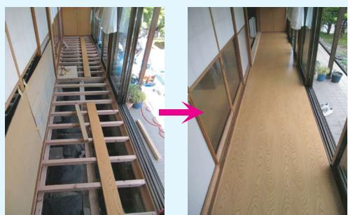
【縁側床張替え工事】縁側の床材が古くなったとのことで張替え工事をしました。床をめくりタルキを入れ直し、断熱材充填後、縁甲板のフローリングを張りました。合わせて壁の塗り替えもさせて頂きました。
