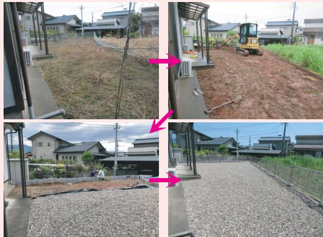
【アルミフェンス工事】積雪で破損した古い鉄製のフェンスをアルミフェンスに取替えさせて頂きました。また、重機で不陸整生後、防草シートを敷き、その上に珪石を敷きました。これからはお手入れが楽になりますね。
