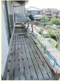
↑木造のベランダが腐食して危険なので解体し、アルミのベランダを施工します。大工さんに解体してもらいました。
