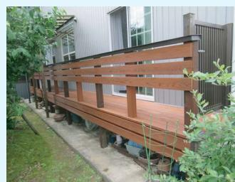
【ウッドデッキ修繕工事】こちらもムラケン通信地域配布からの新規のお客様。ウッドデッキが腐食してきたので修繕しました。土台や柱などは補強し再利用していますが、新品のウッドデッキによみがえりました。
