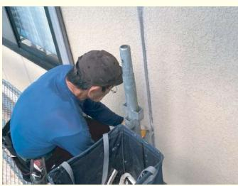
←屋根の修繕工事中ですが、足場を組んだついでに外壁のシリングの打ち替えを追加でさせて頂きました。地上から見てもわからないのですが、足場上だとシリングの亀裂や収縮がはつきりと見て取れました。
