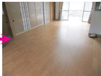
↑LDKの床の修繕工事。既設床材が弱っていたため、下地合板を更に張って、フローリングを張りました。三重張りですね。
