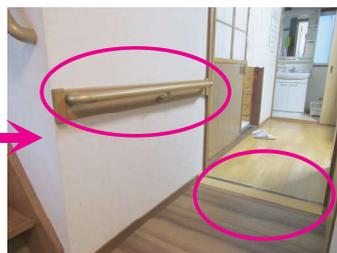
↑介護保険を適用してのバリアフリー工事。引き戸の跨ぎ敷居を取り除き、段差を解消しました。既存の引き戸は高さを調整して再利用しました。また廊下の手摺りの取付けもしました。
