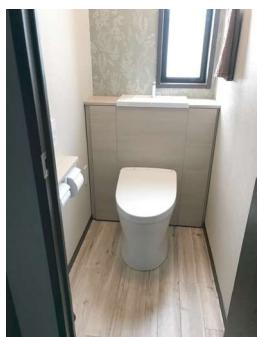
←トイレ改修工事。背面のタンクが隠れていて、スッキリとしたデザインになっています。
