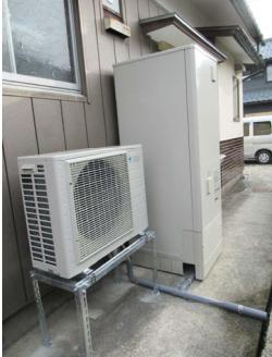
■電気温水からエコキュートへの取替え工事をさせて頂きました。また洗面化粧台の入れ替えもさせて頂きました。
