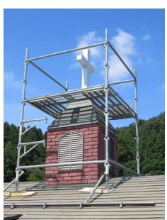
■木製の十字架が風雨により傷んだので、雨にも耐えるように、鉄板で巻き込む形で修繕させて頂きました。
