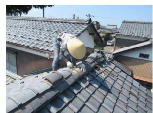
■屋根瓦の修繕工事をさせて頂きました。棟瓦の修繕や雨漏り箇所の対応をしました。雨樋の掃除もあわせてしました。
