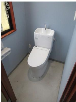
←テナント用のトイレを新設しました。TOTOのトイレ、内装は落ち着いた雰囲気に仕上がっています。床はモルタル塗りにて仕上げました。
