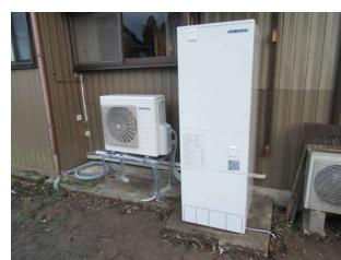
■電気温水器が故障したので、新しくエコキュートに入れ替えをしました。
