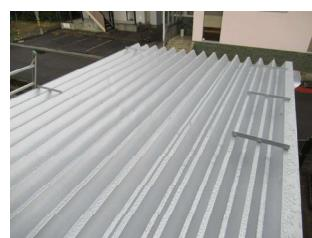
■車庫の折板屋根の塗装工事をさせて頂きました。3回塗って仕上げました。
