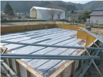
■外廻りの型枠を組み、基礎鉄筋を組んでいきます。
