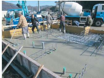
■土間にコンクリート打設。快晴でコンクリ日干しでした。
