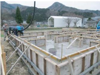
■立ち上りの基礎コンクリート打設中。
