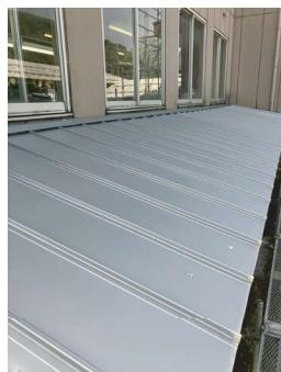
■下屋が傷んできただため、葺き替え工事をさせていただきました。以前は横平葺きでしたが、今回は縦平葺きにて施工しました。こちらの方が水切れもよく、長持ちします。
