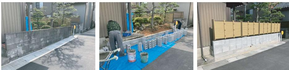
■ブロックの積み替え工事の後、フェンス工事をしました。スッキリとした外観に。
