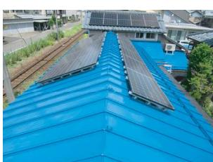
■瓦棒屋根の塗装修繕をさせていただきました。錆を落として下塗りをし、上塗りを2回しました。
