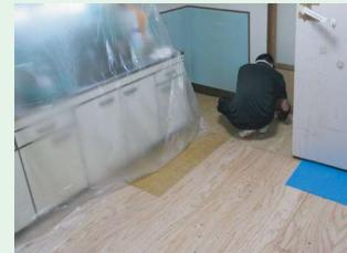
■台所の床張り前に下地の補強をしています。
