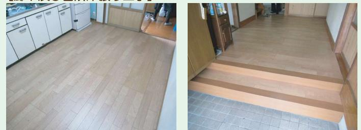
台所の床がフワつくとのことで床張り工事をご依頼頂きました。経年劣化と共に傷んだ玄関廊下も併せて工事しました。下地補強をしてから上張りにて施工しています。
