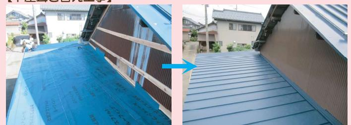
倉庫の下屋の葺き替え工事をしました。経年劣化で傷んできたとのことで張替えのご依頼です。併せてその面の波板壁も張り替えました。また雪止めも取付けました。
