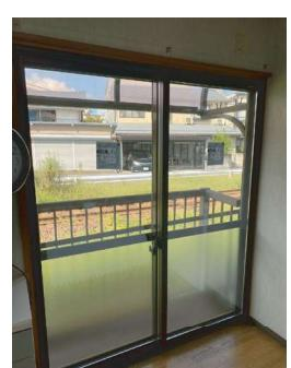
■2カ所の掃出し窓に内窓を取り付けました。断熱だけでなく防音効果も高くなりますよ。
