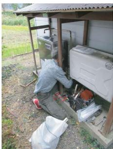
■ 灯油ボイラーの入替え工事をしました。機器を交換することで、弱くなっていた給湯の圧力が良くなりました。
