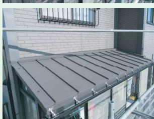
■毎年の落雪によりサンルームの屋根が破損しました。今後もまた落雪による被害が想定できるため、その上から屋根を作ることをご提案させていただきました。強固な屋根に仕上がりました。
