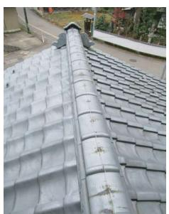
■鉄製の棟番線が積雪などによる劣化で切れてしまいまし
