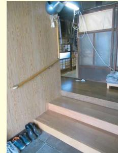
■介護保険を適用して、手摺りの取付け工事をさせていただきました。また玄関の段差が大きかつたので、あわせて踏み台を追加しました。
