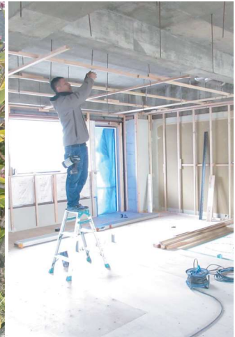
改装工事の現場。 大工さんが天井下地中。
