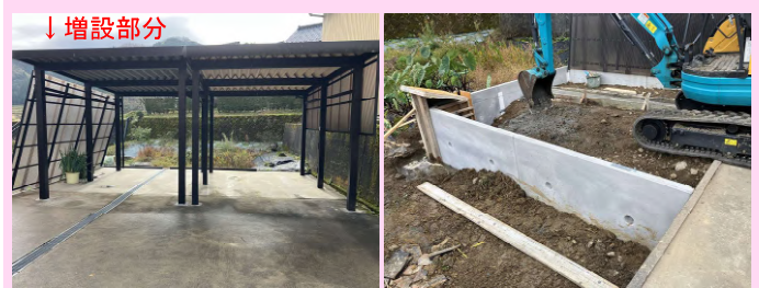
↓増設部分 ■カーポート増設のご依頼。隣は低い畑になっていたため、土留めや盛り土工事を行い、その部分にカーポートを設置しました。
