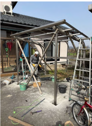
サイクルポートの 設置工事をしています。
