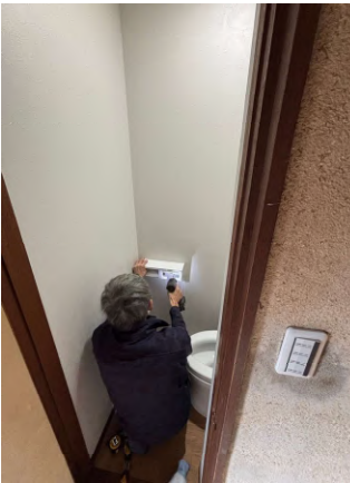
トイレ改装工事の現場。 設備を取り付けています。
