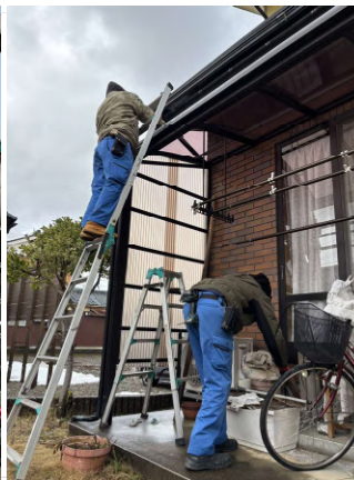
落雪で穴があいたテラス屋根を 修繕しています。
