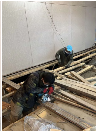
遠成寺さんの改装現場。 まずは床の解体から。
