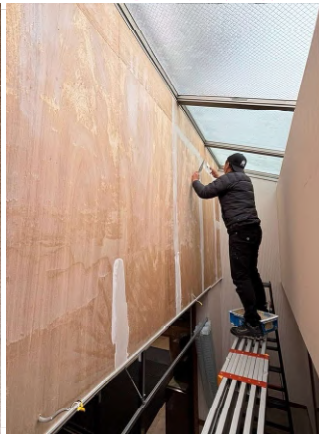
クロス張りの現場。 下地の処理をしています。
