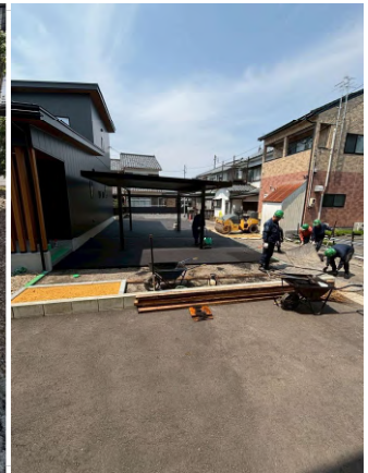
冬の間できなかった外構工事。 アスファルト工事中。
