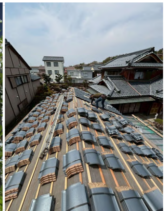
屋根瓦を葺き替えています。 春になり瓦修繕が多いです。
