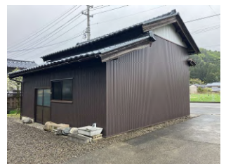
■小屋の構造補強工事と外装工事をしました。
