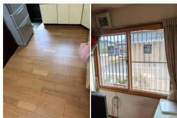
■床張り工事と内窓取付け工事をさせていただきました。
