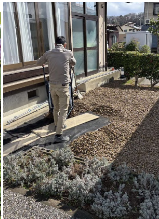
外構工事の現場。 防草シートの上に珪石敷き。
