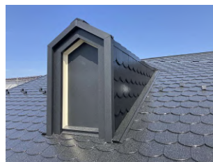
■経年劣化した飾り屋根の修繕と屋根の塗装。
